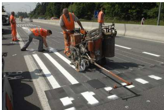
Figure 2 – Application d'un système à base de peinture
