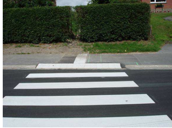
Illustration 8 : Inflexion mal réalisée, équivalent à une bordure bateau
