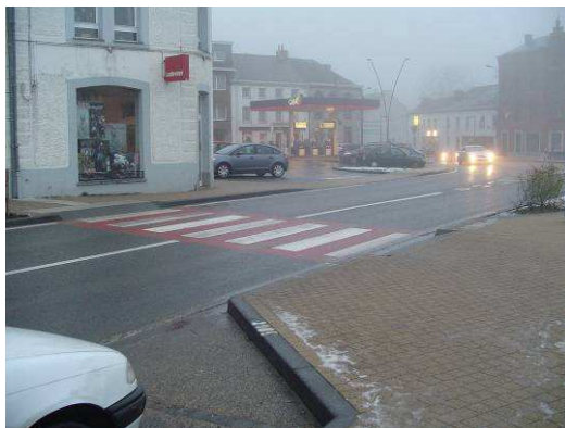
Illustrations 1 et 2 : traversées partiellement équipées de dalles podotactiles pour les personnes déficientes visuelles
