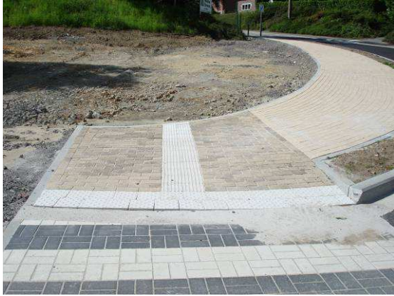
Illustration 7 : Inflexion correctement réalisée
