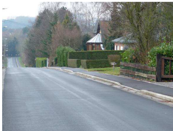
Illustration 9 : la continuité entre trottoir et chaussée est en pratique inexistante suite à un travail bâclé,
