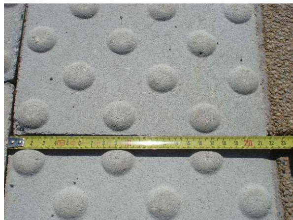
Illustration 6 : Largeur de dalle trop étroite, 44 cm au lieu de 60 cm
