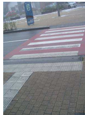
Illustrations 1 et 2 : traversées partiellement équipées de dalles podotactiles pour les personnes déficientes visuelles
