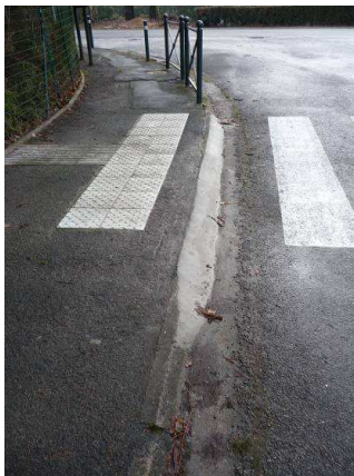
Illustration 9 : la continuité entre trottoir et chaussée est en pratique inexistante suite à un travail bâclé,
