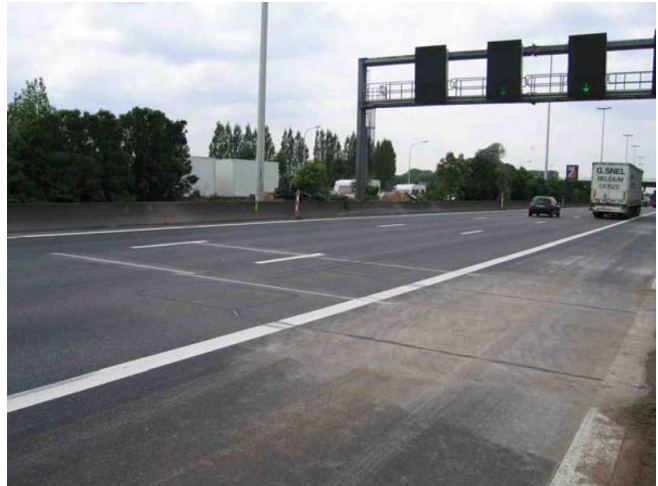
Vue du site pilote de Ranst (photo MOW)
