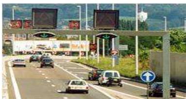
Figure 4 Panneau de régulation de voie
