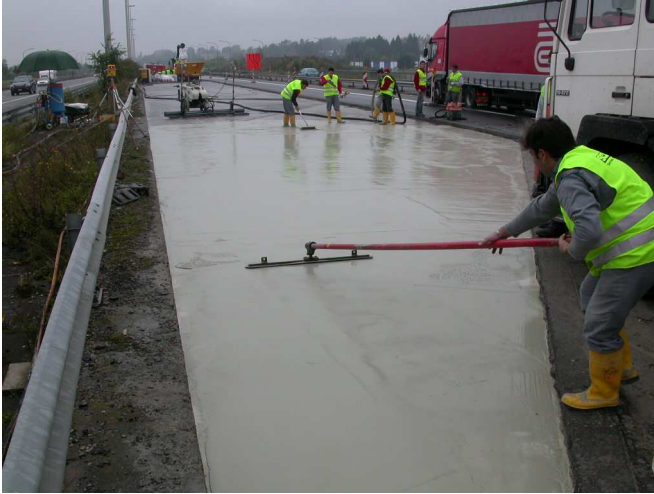
Illustrations 4 et 5 : mise en œuvre de mortier de correction de tablier
