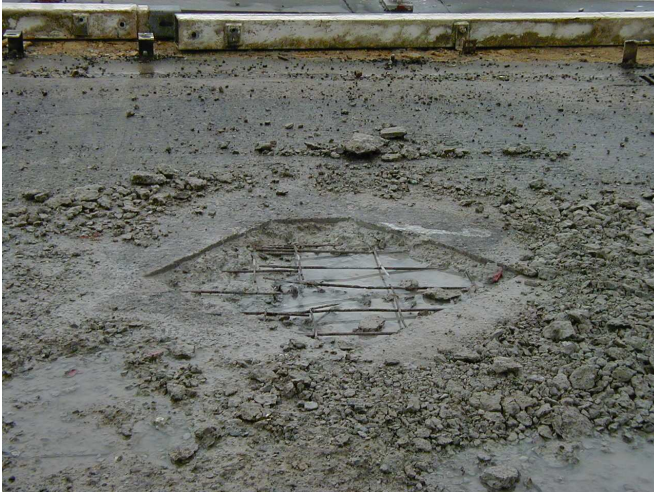
Illustration 2 : décapage d'une zone à réparer au mortier de ragréage
