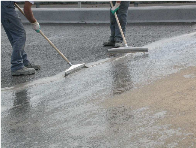
Illustration 3 : mise en œuvre de mortier de tiré-gratté époxy
