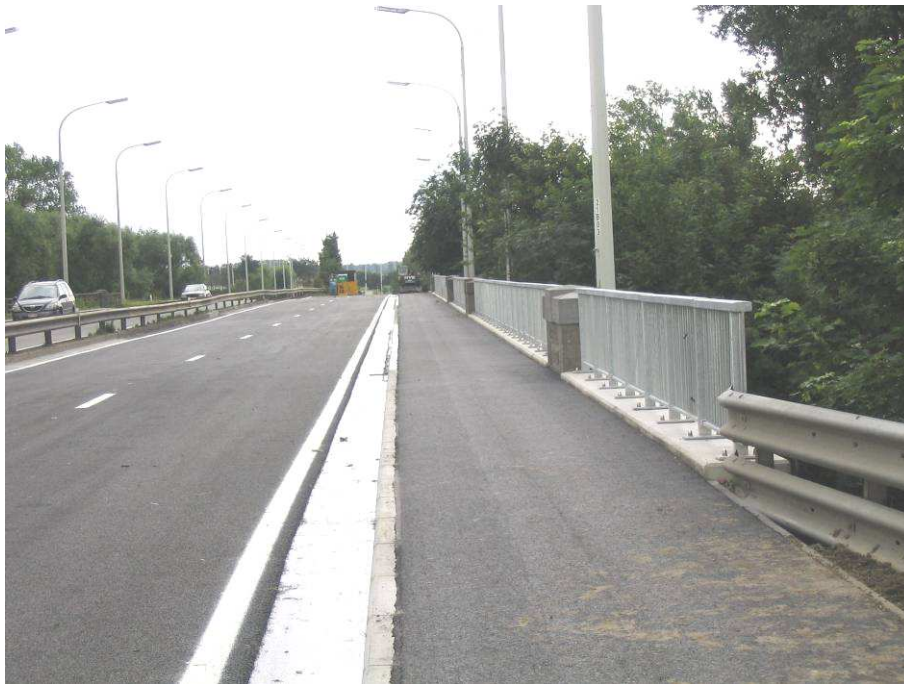
Algemeen zicht op het brugdek na de werken
