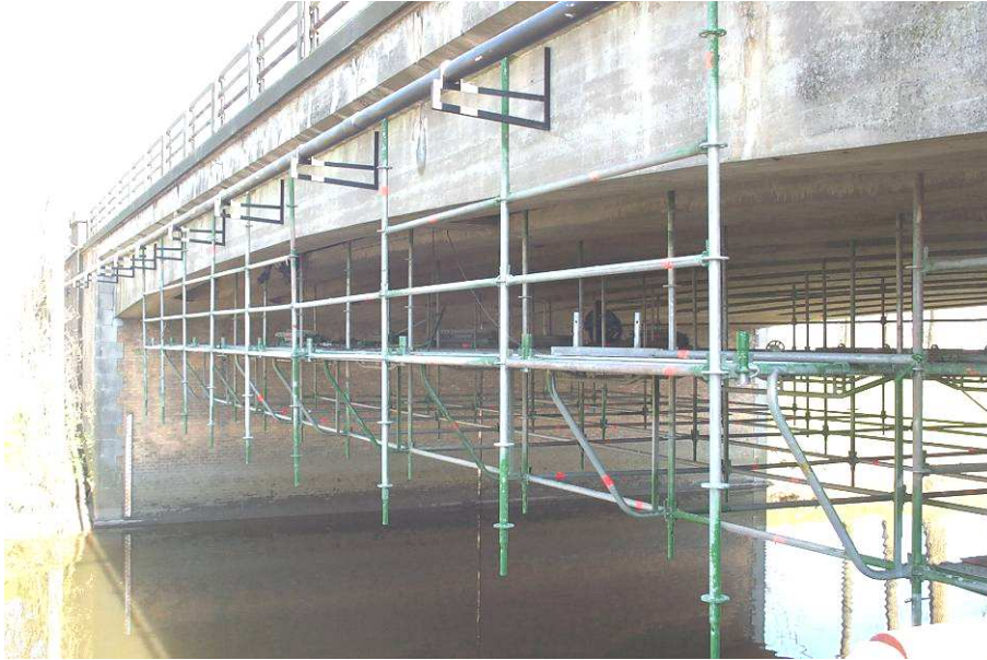
Werkplatform opgehangen aan de brug
