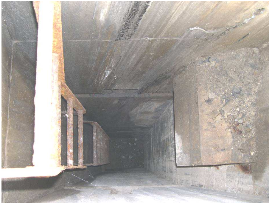
Schouw achter landhoofd en verankering naspankabel (rechts)
