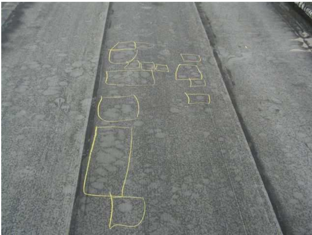
Illustration 3 : Taches blanchâtres correspondant à des zones non-adhérentes
