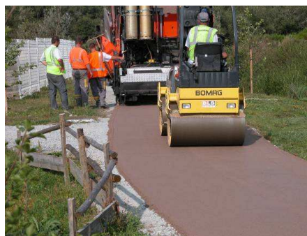
Photos 6 et 7 - Mise en œuvre d'enrobés à froid fabriqués avec de l'émulsion de liant végétal.
