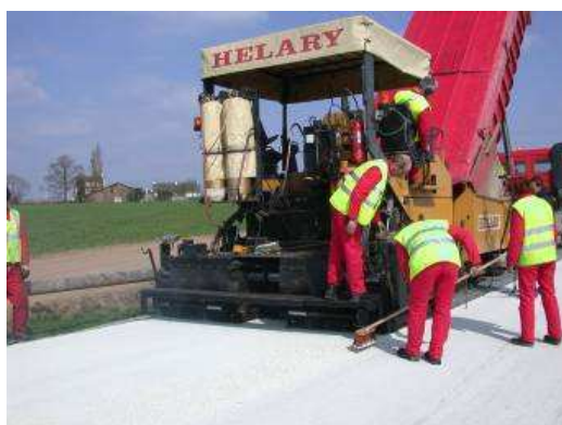
Photo 3 - Mise en oeuvre des tous premiers enrobés au liant végétal (couleur blanche)
