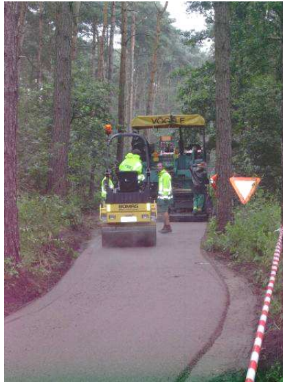
Figuur 2 : Aanleg van een fietspad op basis van een plantaardig bindmiddel tussen Hechtel-Eksel en Beringen
