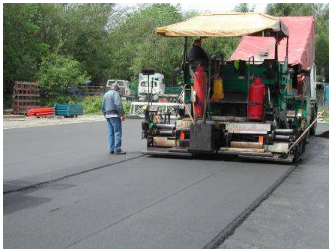
Figuur 1 : Aanleg van lage-temperatuur asfalt
