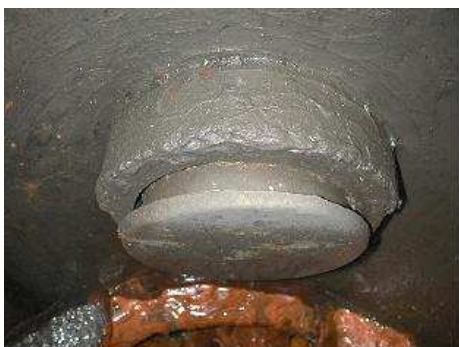
Foto 5 : Afdichtingstop op drainaigeleiding
