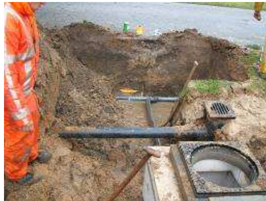
Figuur 12 : Aanleg hoofdstreng drukriolering Figuur 13 : Aansluiting pompunit - hoofdstreng
