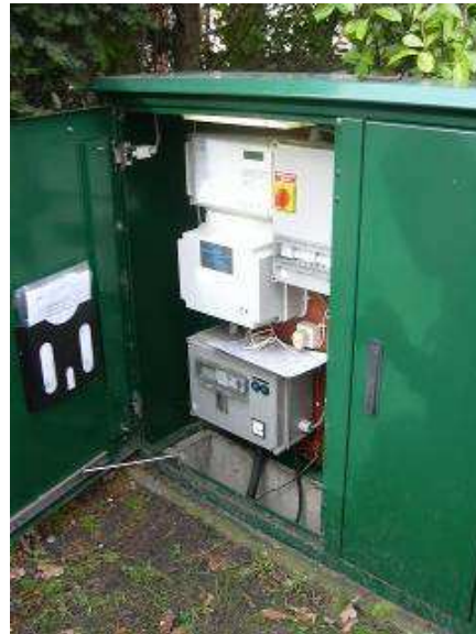
Figuur 17 – Centrale voedingskast met sturing
