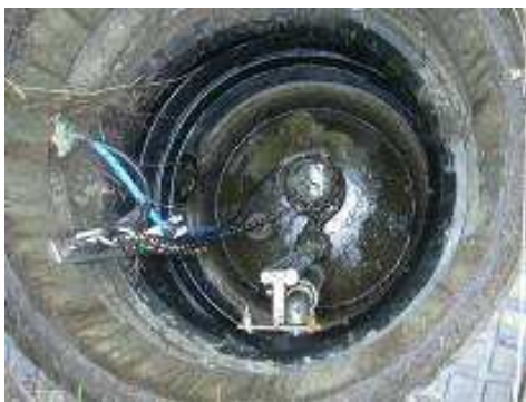
Figuur 18 : Montage pomp aan geleidingsstang
