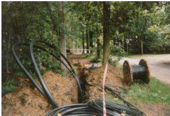
Figuur 12 : Aanleg hoofdstreng drukriolering Figuur 13 : Aansluiting pompunit - hoofdstreng
