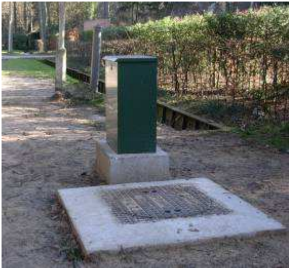
Figuur 16 : Afgewerkte pompunit
