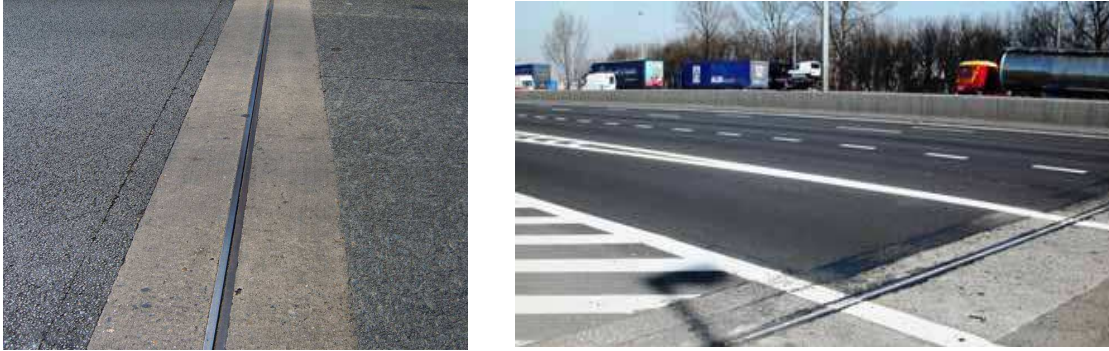
Figuur 5 : realisatie van de eindvoeg op de Ring van Antwerpen
