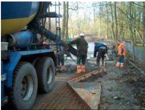
Fig.12 gieten van beton
