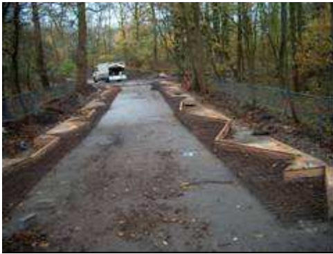
Fig. 11 leggen van randbekisting
