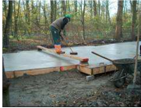
Fig. 14 borstelen van de beton
