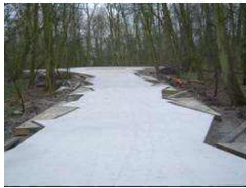
Fig. 15 losmaken van de randkisten
