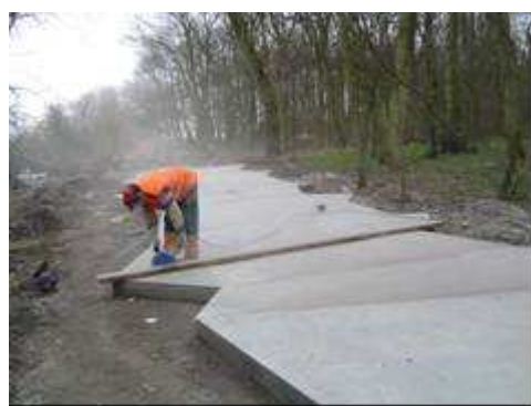
Fig. 16 zagen van de schijnvoegen
