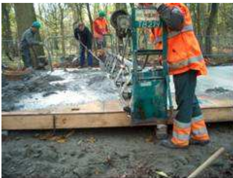
Fig. 13 aftrillen van beton
