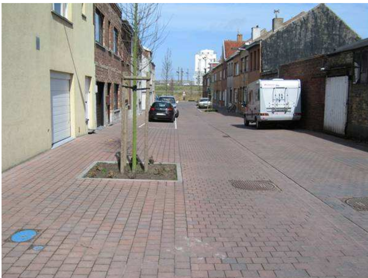
Figuur 12 – Foto uitgevoerde weg als “verblijfstraat”
