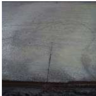
Figuur 16 : Vanaf 6 tot 24 uur na het betonneren, afhankelijk van de temperatuur en dus de uithardingsnelheid, worden voegen gezaagd tot 1/3 van de betondikte. Het beton zal dan in de loop van de volgende dagen verder scheuren onder die zaagsnede zodat de verharding verdeeld wordt in platen tot 4,5 m lengte.
