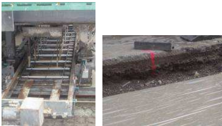
Figuur 5 en 6 : De deuvels worden hetzij vooraf op stoelen geplaatst, hetzij – zoals hier op de foto te zien is – rechtstreeks door de machine in het verse beton getrild. Een duidelijk merkteken duidt aan waar later de zaagsnede dient aangebracht te worden.
