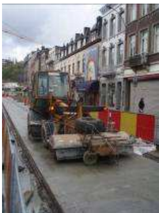
Figuur 17, 18 en 19 : Na het zagen wordt de cementmelk van het betonoppervlak met water weggeborsteld. Zo ontstaat een uitgewassen oppervlak met heel goede eigenschappen van stroefheid en rolgeluid.
