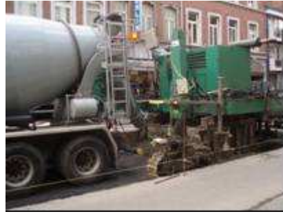
Figuur 2 : Het beton wordt met kipwagens of truckmixers aangevoerd en gelijkmatig verdeeld vóór de glijbekistingsmachine
