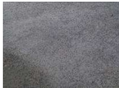
Figuur 17, 18 en 19 : Na het zagen wordt de cementmelk van het betonoppervlak met water weggeborsteld. Zo ontstaat een uitgewassen oppervlak met heel goede eigenschappen van stroefheid en rolgeluid.
