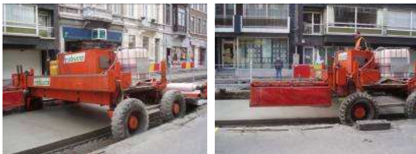
Figuur 13 en 14 : Onmiddellijk na het betonneren wordt een bindingsvertrager verstoven op het betonoppervlak. Die verhindert de uitharding van de cementmelk aan het oppervlak.
