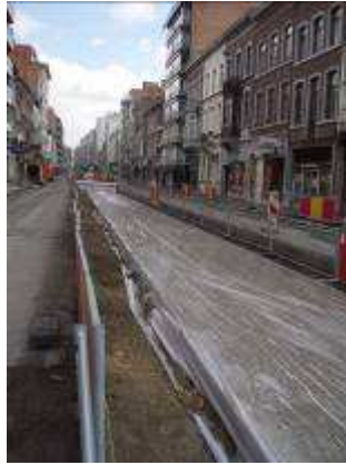
Figuur 15 : Het oppervlak wordt vervolgens afgedicht met een plasticfolie. Die verhindert de verdamping van de bindingsvertrager maar biedt bovendien een perfecte bescherming tegen uitdroging door wind en zonneshijn.
