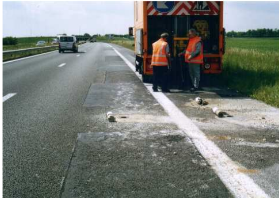
Figuur 1 Zicht op de kernboringen
