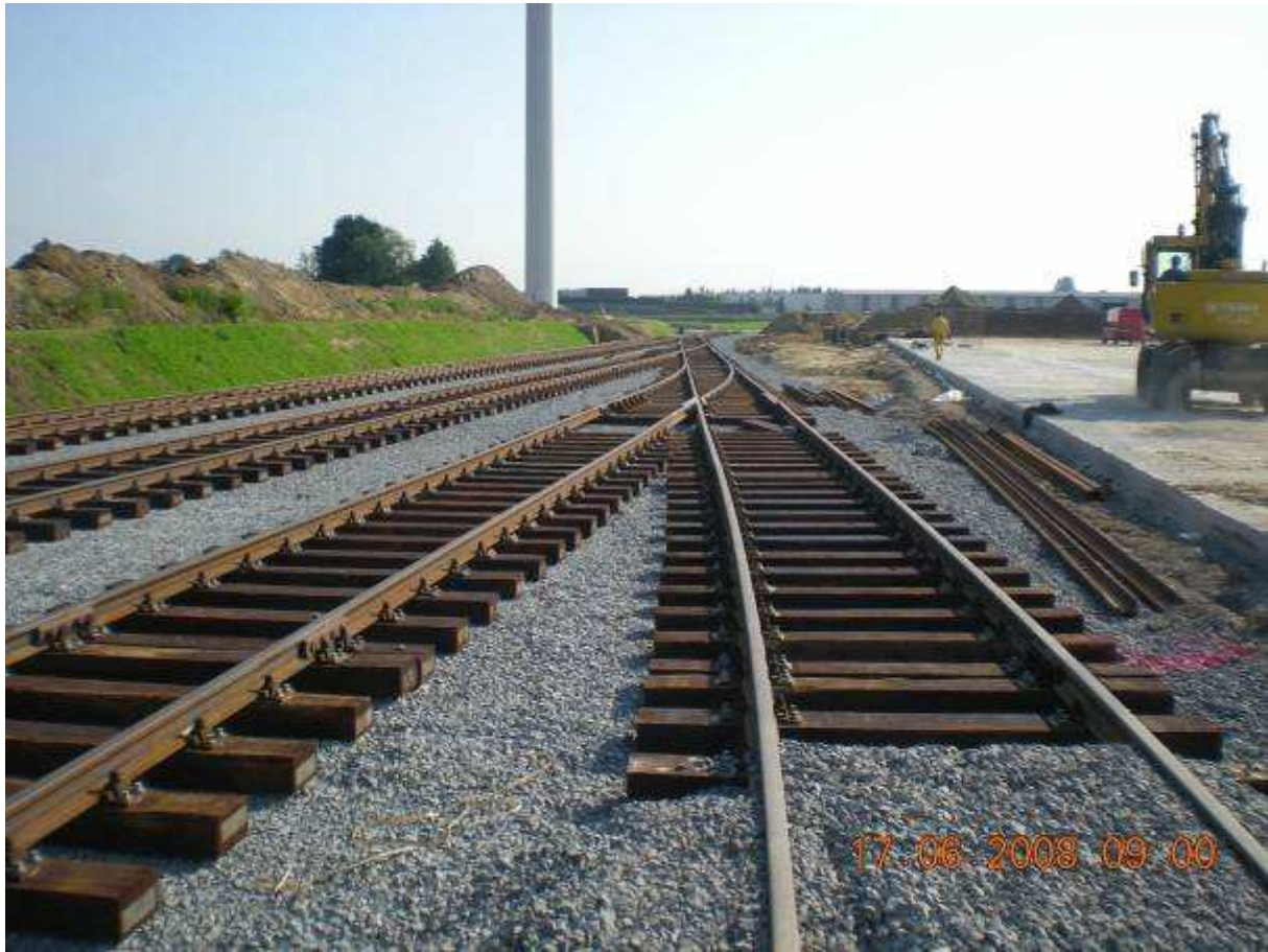
FOTO AANLEG SPORENBUNDEL
