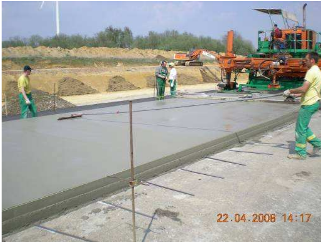
FOTO PLAATSING BETON
