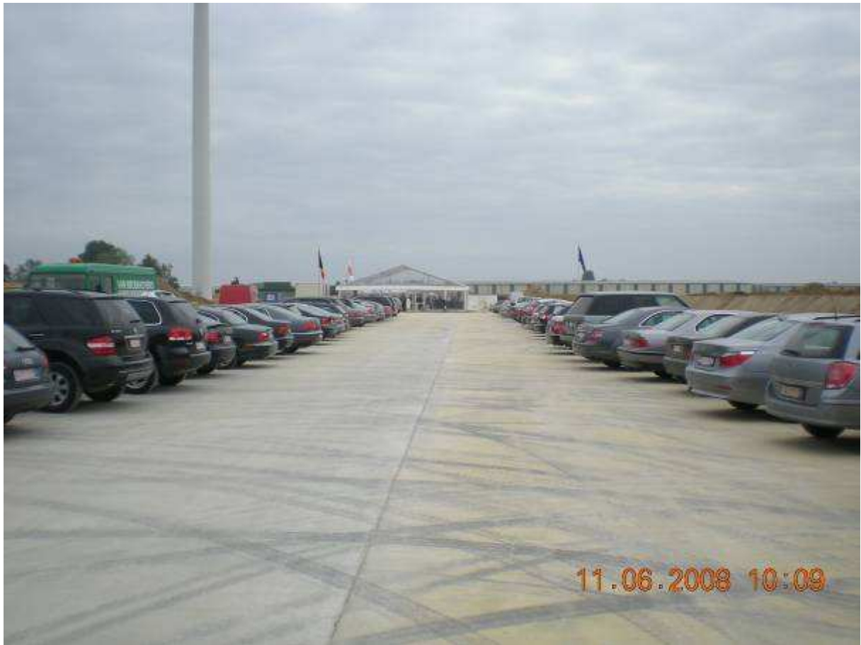
FOTO AFGEWERKTE BETONVERHARDING
