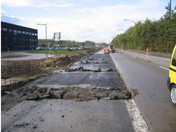
Fig. 4: Uitgraving in functie van de verankeringribben.
