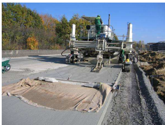
Fig. 3: Afwerking van het DGB met supersmoother.
