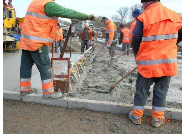
Fig. 12: Aanleg van het beton ter hoogte van de rotonde met trilbalk.
