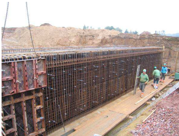
Fig. 13: Wapening van de tunnelkoker.
