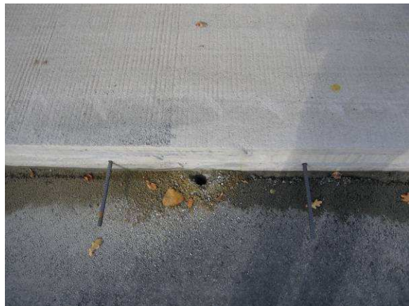
Fig. 7: Zicht op de ankerstaven en een boorgat voor de drainage
