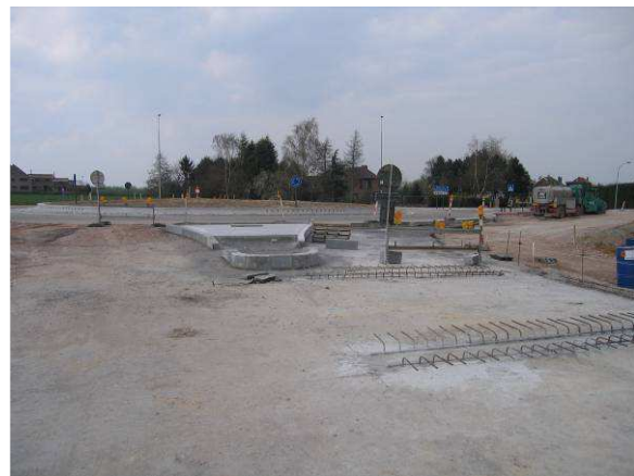
Fig. 10: Verankeringslandhoofden ter hoogte van de aansluiting van de ringweg en de rotonde in DGB.
