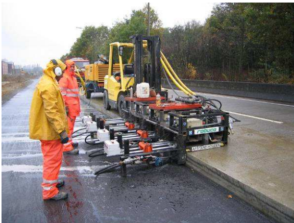
Fig. 6: Inboren van ankers in bestaande structuur.
