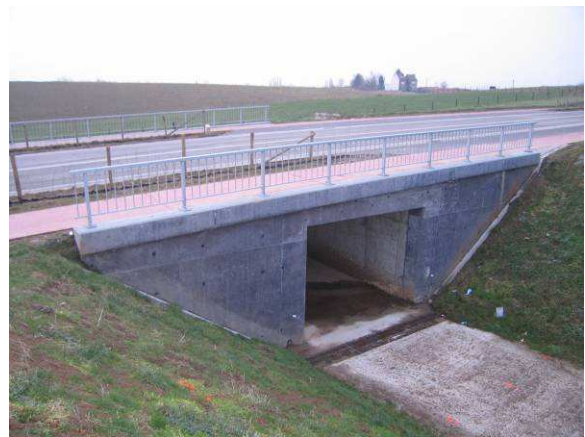
Fig. 14: Betonnen frontmuren van de veetunnel zwart gekleurd in de massa.
