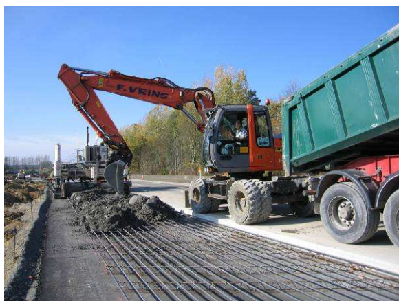
Fig. 2: Aanleg van de rechtse afslagstrook in DGB.
