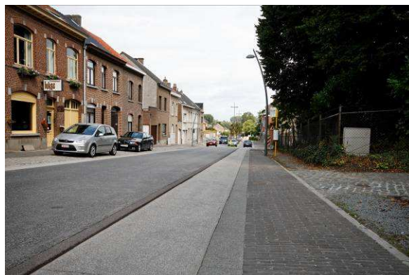
Fig. 15: Bruin beton voor de rijweg en grijs beton voor de fietssuggestiestrook.
