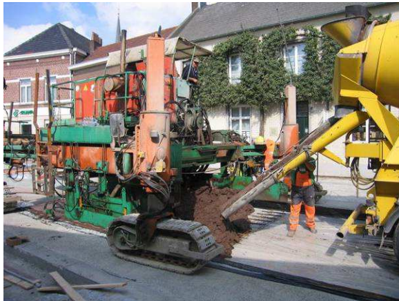
Fig. 18: Aanleg van bruin beton met deussels.
