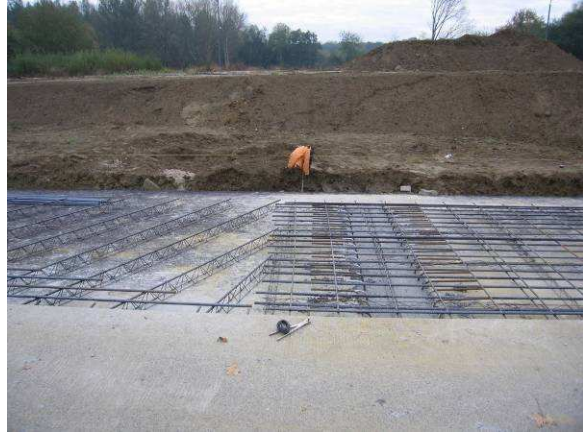
Fig. 5: Overgang wapening ter hoogte van verankeringsribben.
