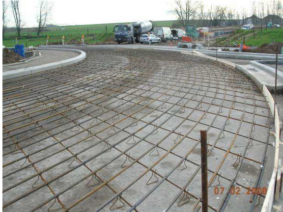
Fig. 11: Rotonde in DBG met een dikte van 23 cm.
