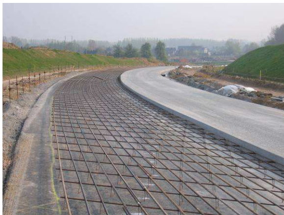
Fig. 9: Ringweg in DGB met een dikte van 23 cm.
