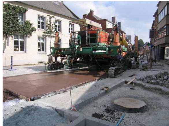
Fig. 19: Afwerking van het beton oppervlak met de supersmoother
