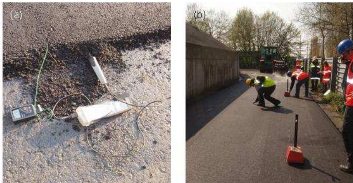
Figuur 4: Foto's tijdens de aanleg van de proefvakken met halfwarm asfalt
