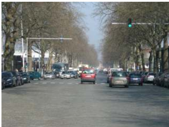
Figure 3 : avenue du Port avant travaux
