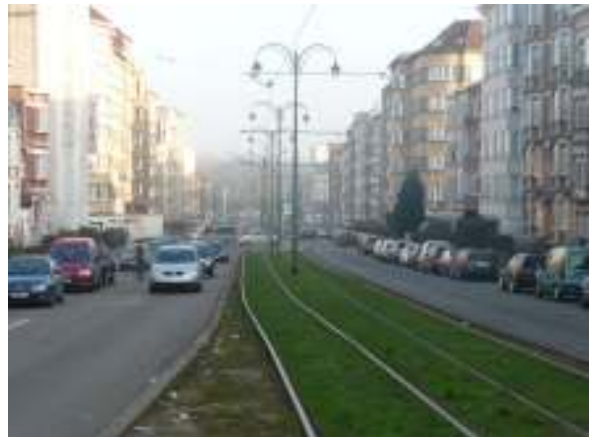
Figure 4 : avenue Charles Woeste avant travaux
