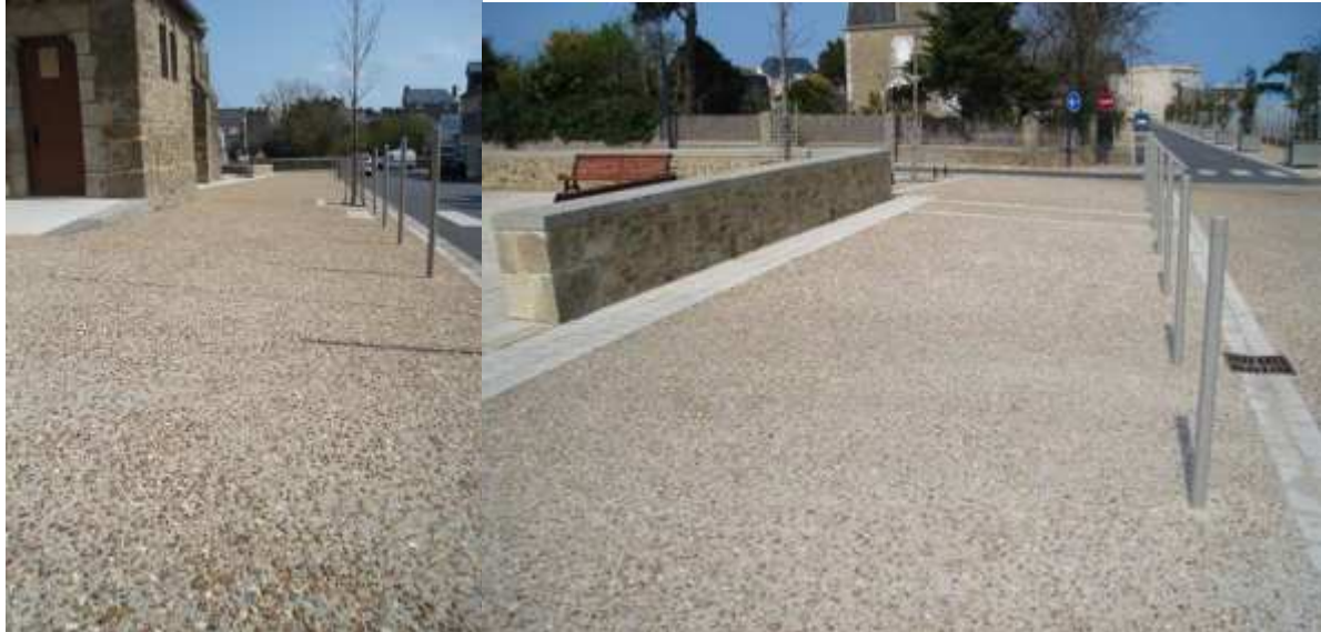
Illustrations 1 : en France, la technique du béton coloré lavé est souvent utilisée pour l'aménagement de trottoirs et autres espaces piétonniers (Saint-Lunaire, département Ille-et-Vilaine).
