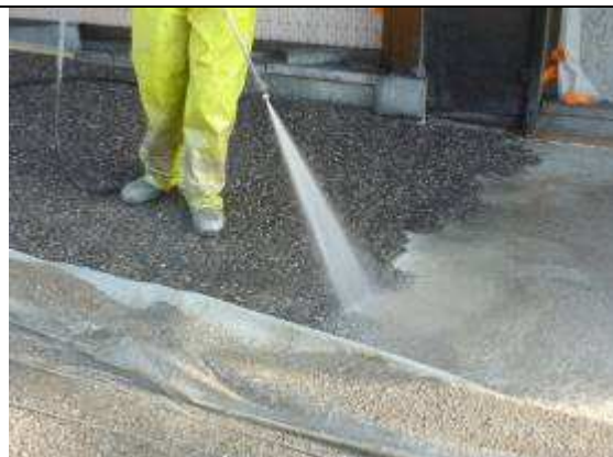
Illustrations 4 : étapes pour la mise en œuvre du béton désactivé
