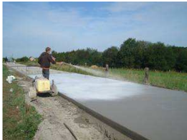
Illustration 7 : pulvérisation du retardateur de prise en surface du béton fraîchement mis en place à Crupet
