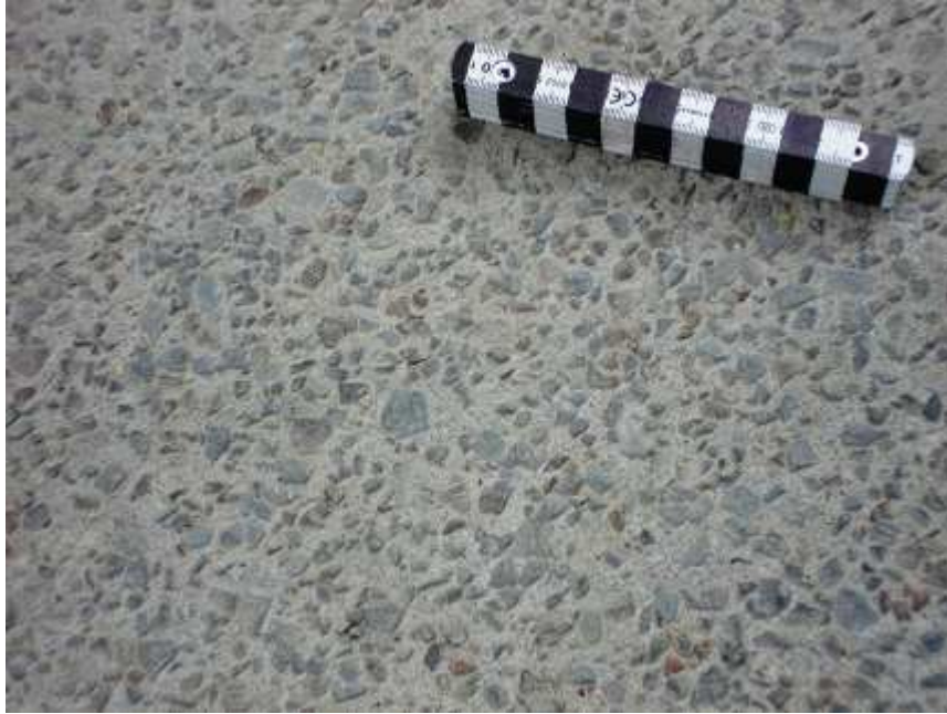
Illustration 8 : aspect du revêtement en béton silencieux de Crupet après dénuadage (Béton 0/14 : sable de rivière 0/4 + grès 2/6 + grès 6/14)
