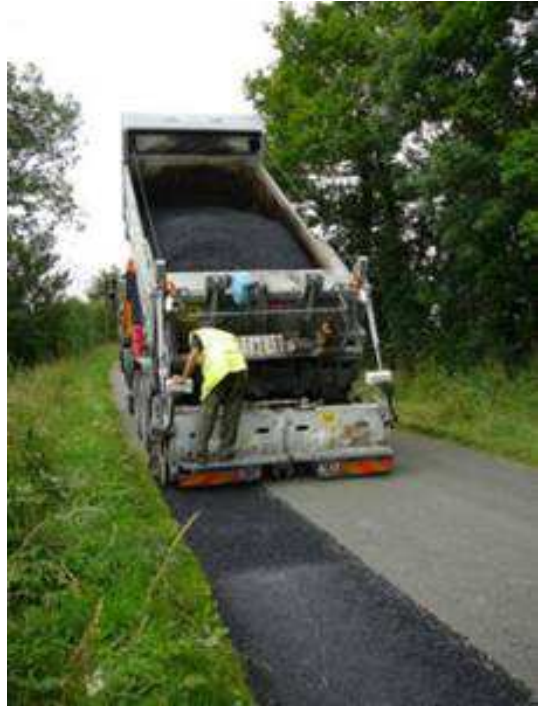
Photos 3 : Reprofilage au FIR
