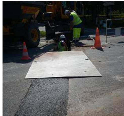
Photo 5 : remplissage de tranchée
