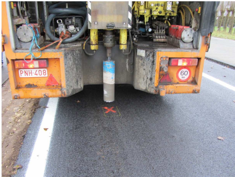
Figuur 4: kernboring op een van de gemarkeerde punten
