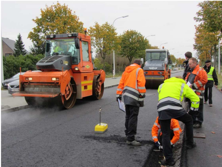
Figuur 2: Troxler meting tijdens het walsen
