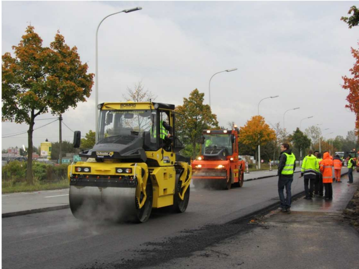
Figuur 1: de proefwals (vooraan) en de werfwals (achteraan)
