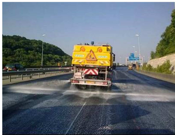
Figure 2 : Répandage de lait de chaux dilué à la saumureuse (crédit photo : SANEF).
