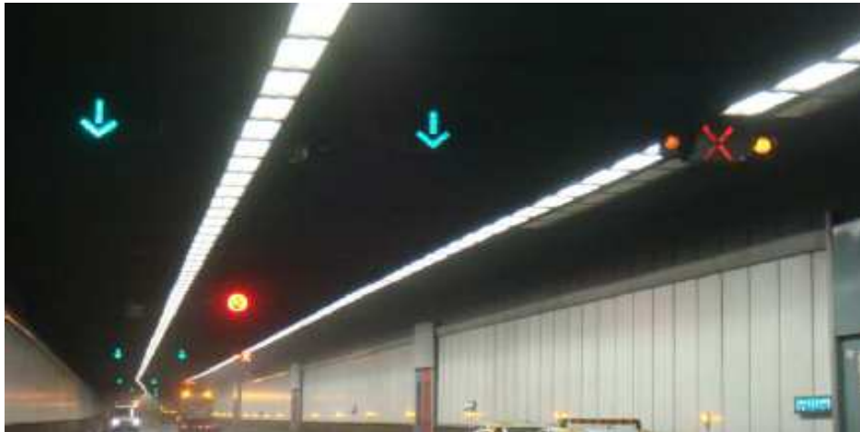
Illustratie 2: rijstrooksignalisatie Belliardtunnel
