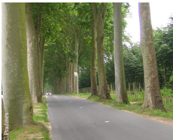
Illustration 3 : Implantation de glissières impossible par manque de place (RD 215, Seine-et-Marne, 1,4 km, 257 platanes, largeur de chaussée 5,20 m, 4500 véh /jour)
