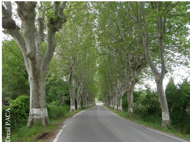
Illustration 2 : Les nombreux accès riverains ont exclu l'implantation de glissières (RD 99, Bouches-du-Rhône, France, 33 km et 3 000 platanes, plus de 8000 véh/jour)
